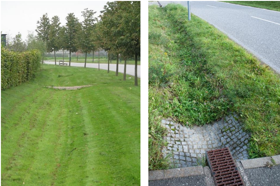
Figur 14. Exempel på svackdike (foto: Tyréns AB).
